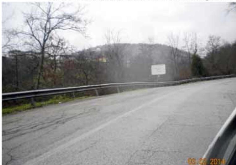
Cedimento evidenziato dall'abbassamento della barriera guard-rail
